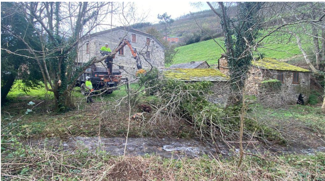
Operarios retirando árbol caído
