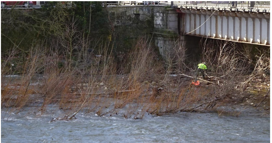
Retirada de arbolado del río Nalón en Sama de Langreo
