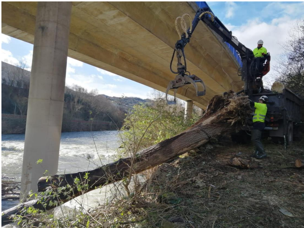
Retirada de arbolado en el río Nalón en Ciaño
