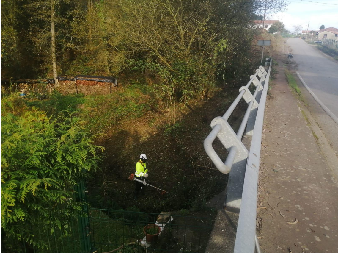
Labores de desbroce
