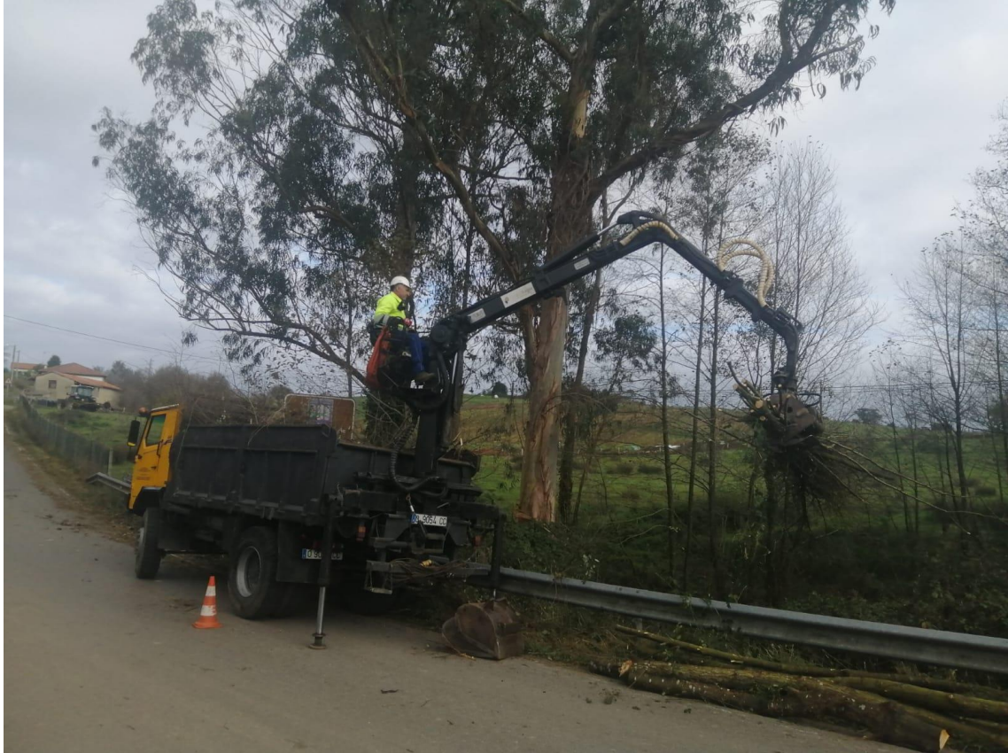
Retirada de restos vegetales
