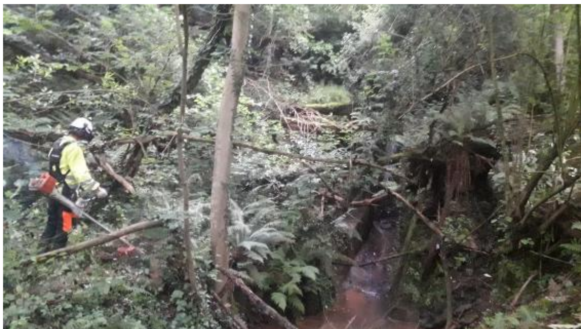
Actuaciones en el arroyo Morgao o Roiles en Mieres
