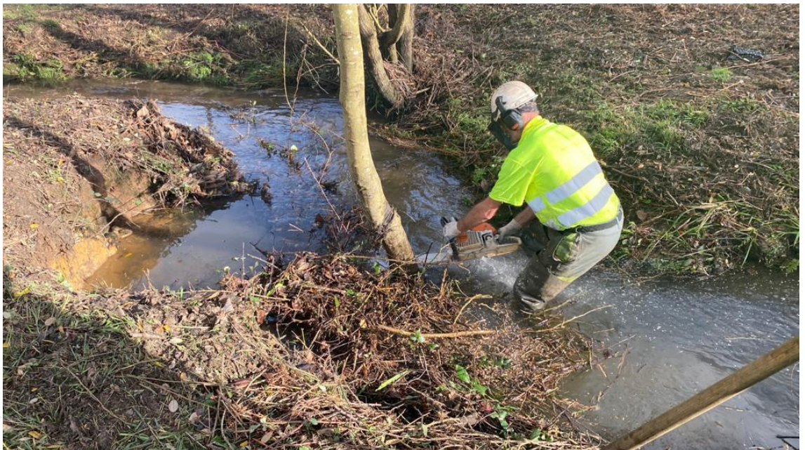
Operario cortando árbol situado en mitad del cauce
