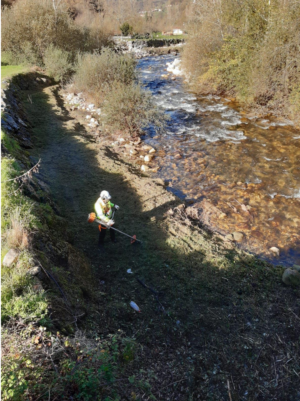
Labores de desbroce
