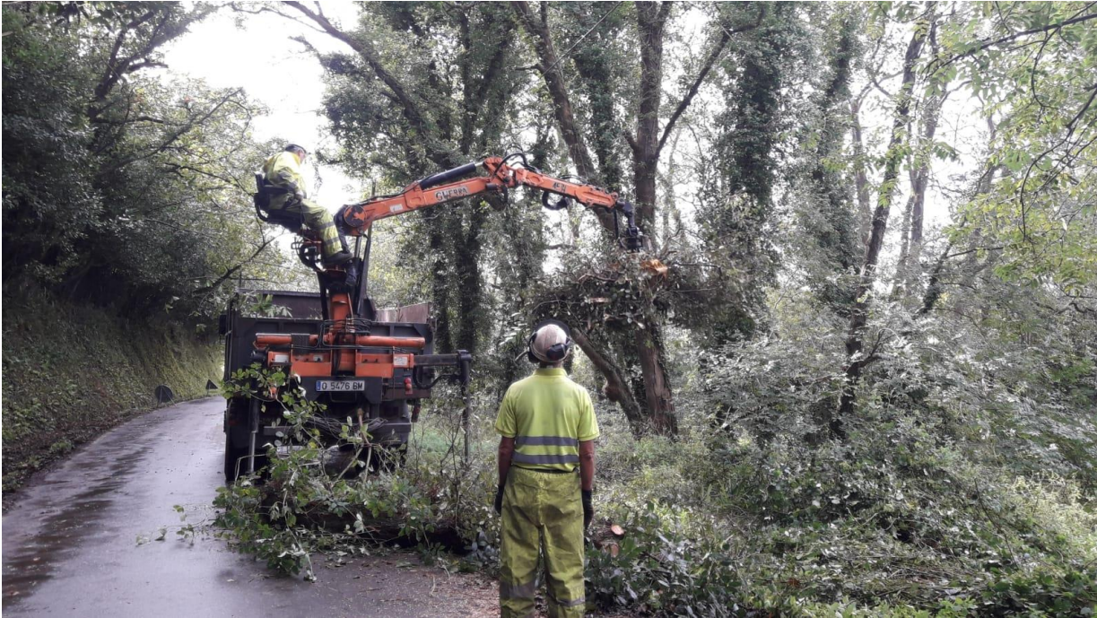
Retirada de arbolado
