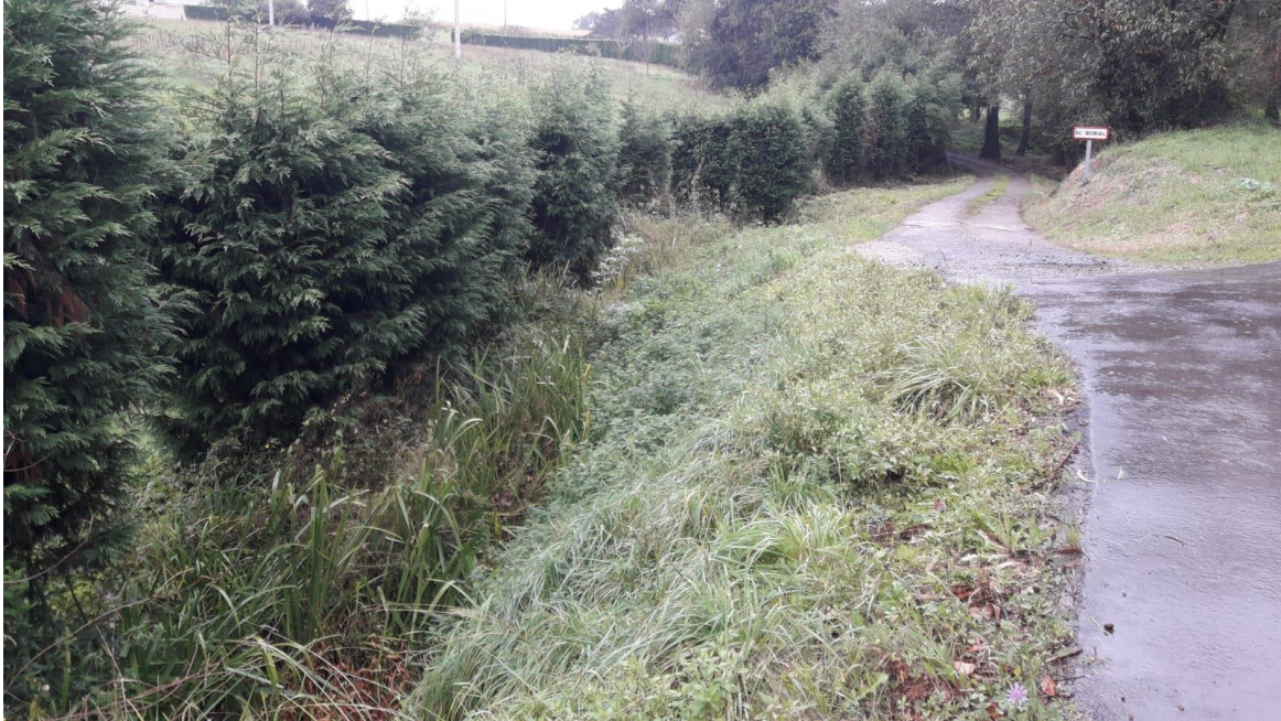
Estado previo a la actuación
