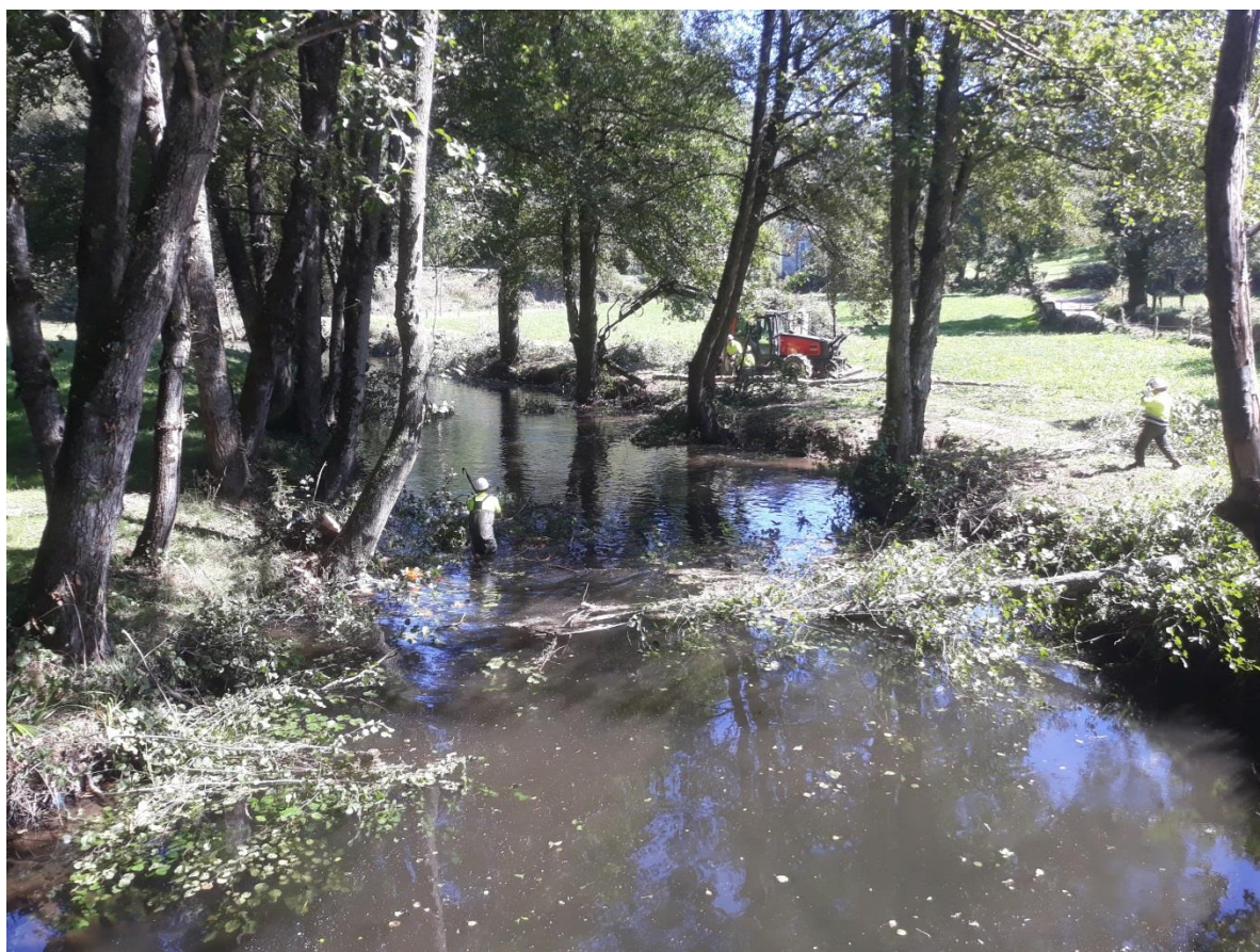
Retirada de arbolado
