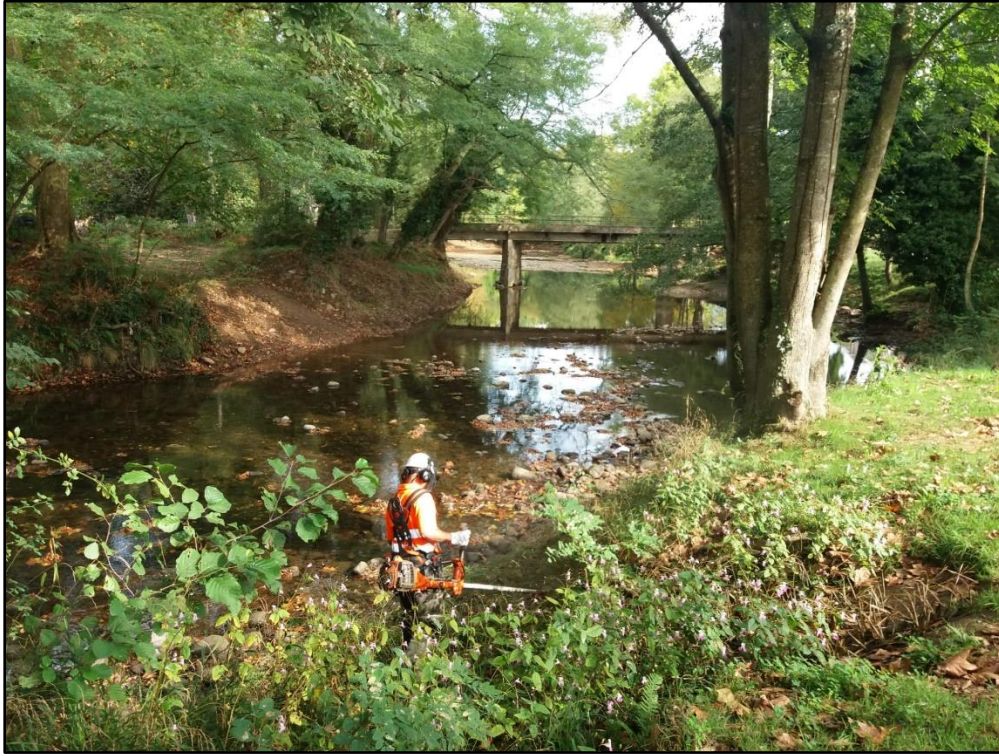
Actuaciones de desbroce
