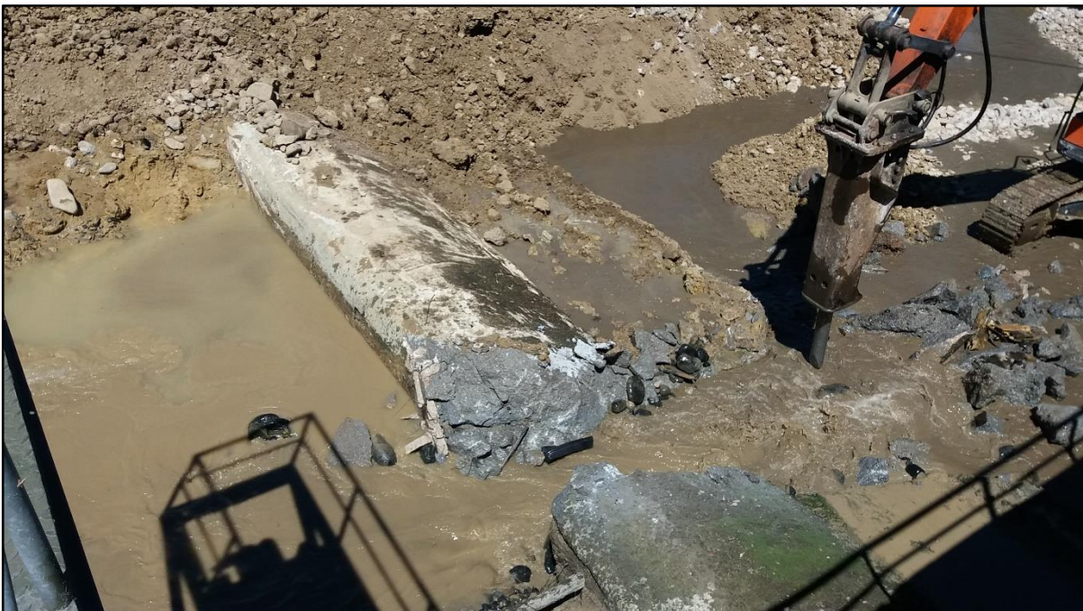
Apertura del azud para posibilitar la construcción de la escala
