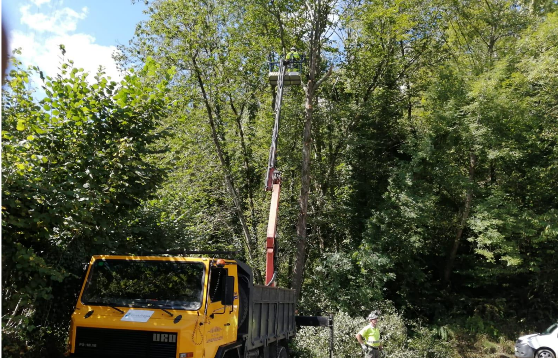
Detalle de los trabajos
