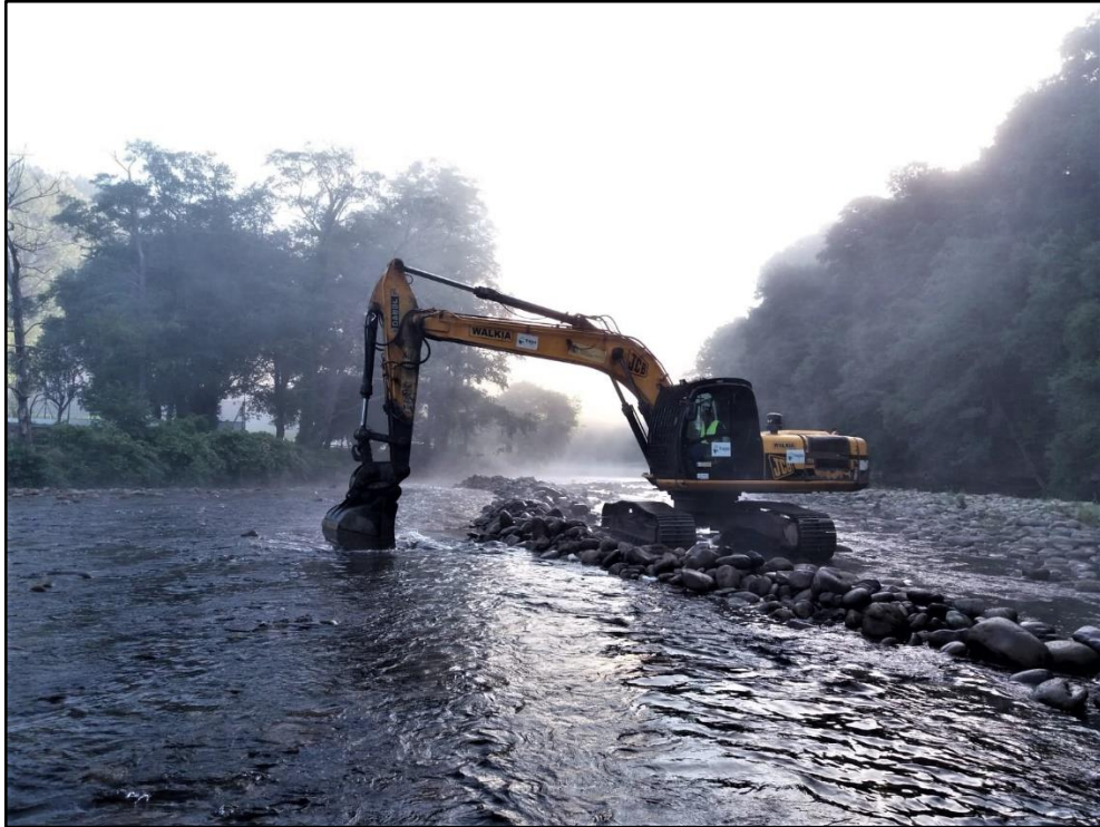
Maquinaria preparando un cordón para evitar enturbiamientos en el cauce
