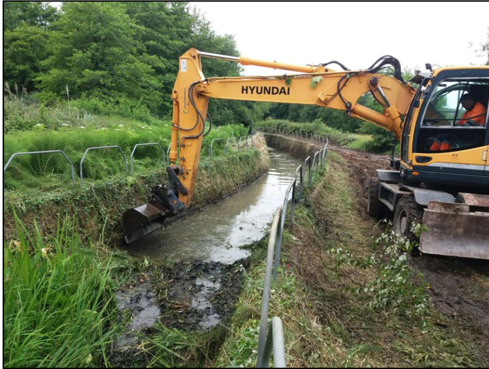
Eliminación de vegetación y sedimentos
