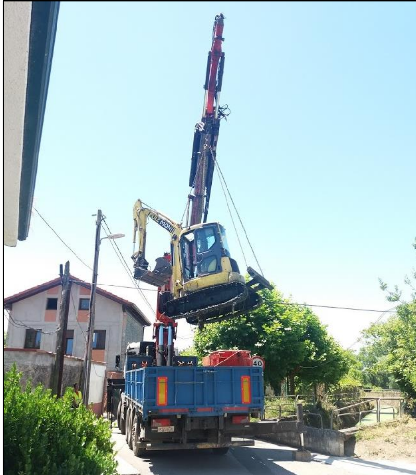
Camión pluma facilitando la entrada al cauce de la maquinaria
