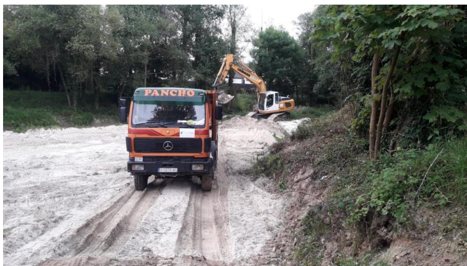
Retirada de las arenas depositadas en la zona de decantación
