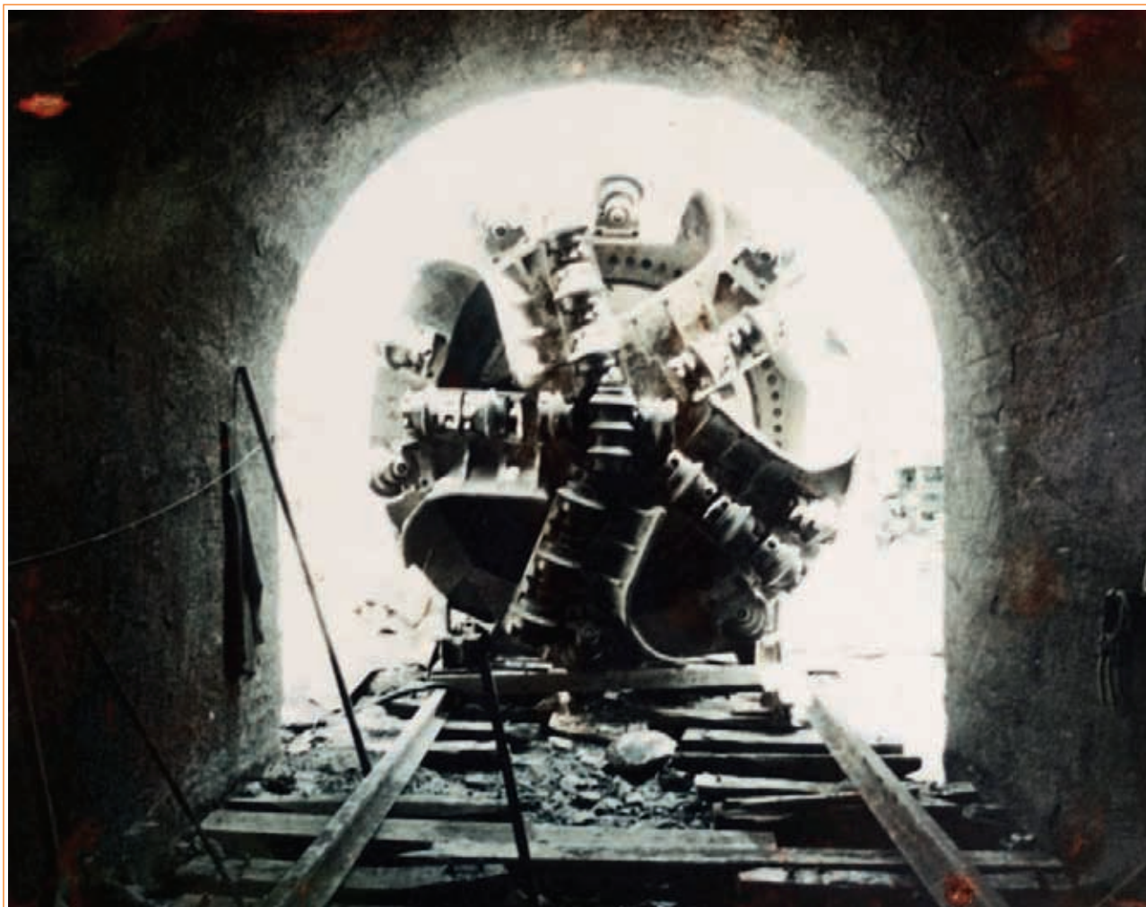
Tuneladora empleada en la construcción de la canalización principal
