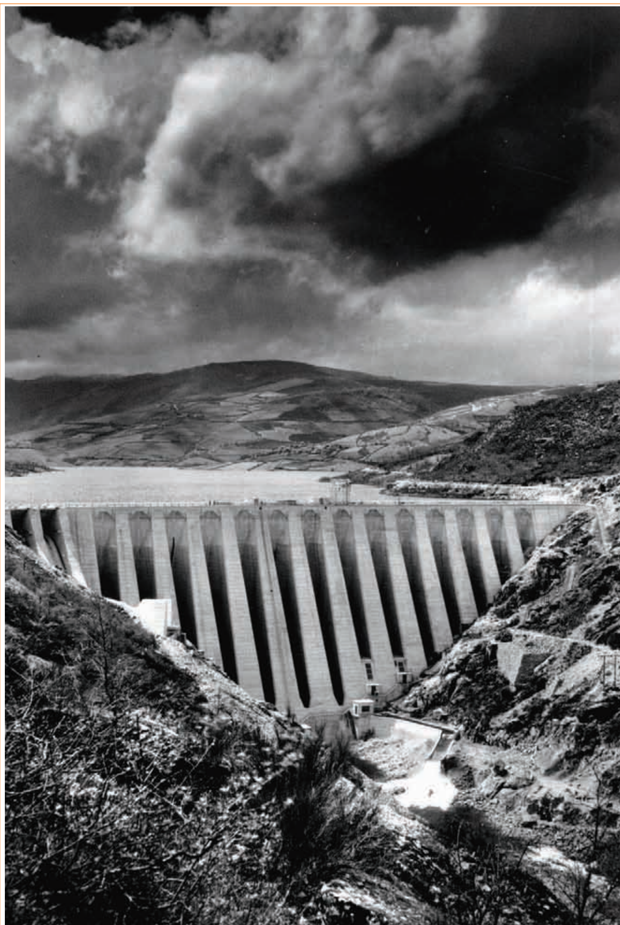
Presas de contrafuertes. Chandrexa de Queixa (Ourense).
