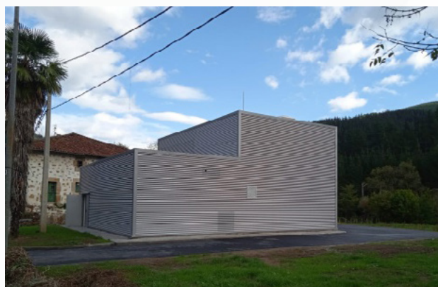
Estación de bombeo Luandio.
