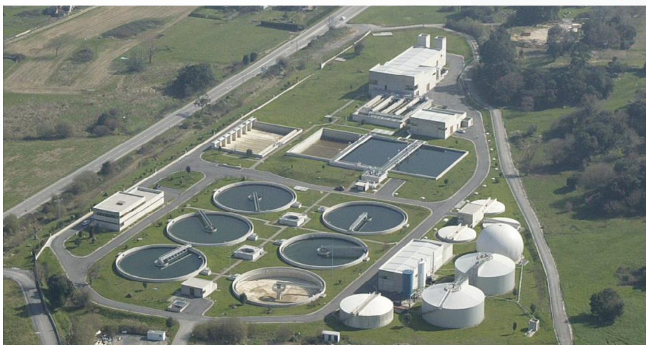
Vista actual de la EDAR de San Pantaleón.
