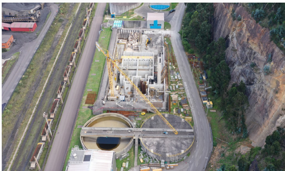
Vista de la EDAR de Gijón Oeste en obras
