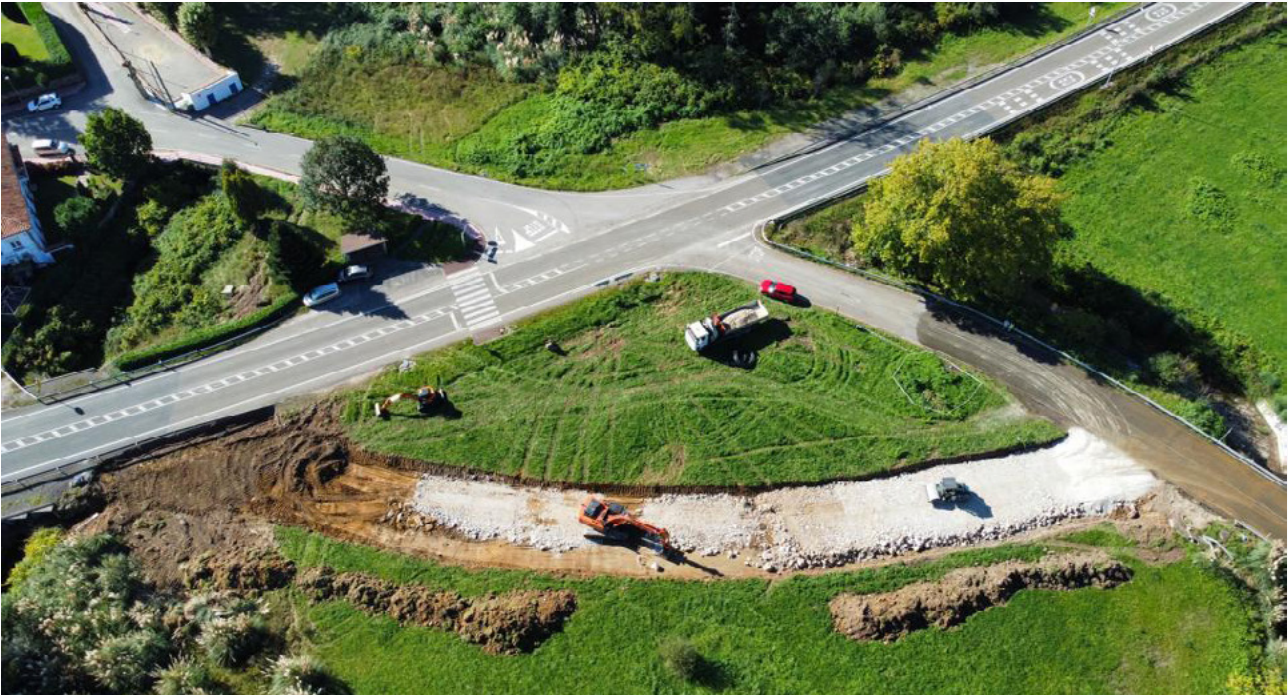
Desvío de carretera para ejecución de obra de drenaje.
