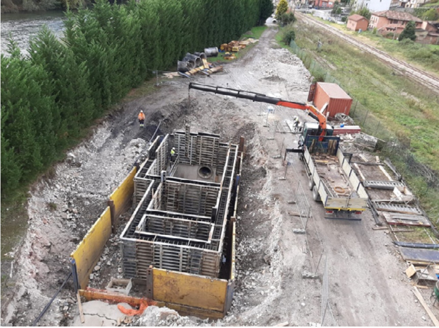
Vista del pozo de bombeo en obras.
