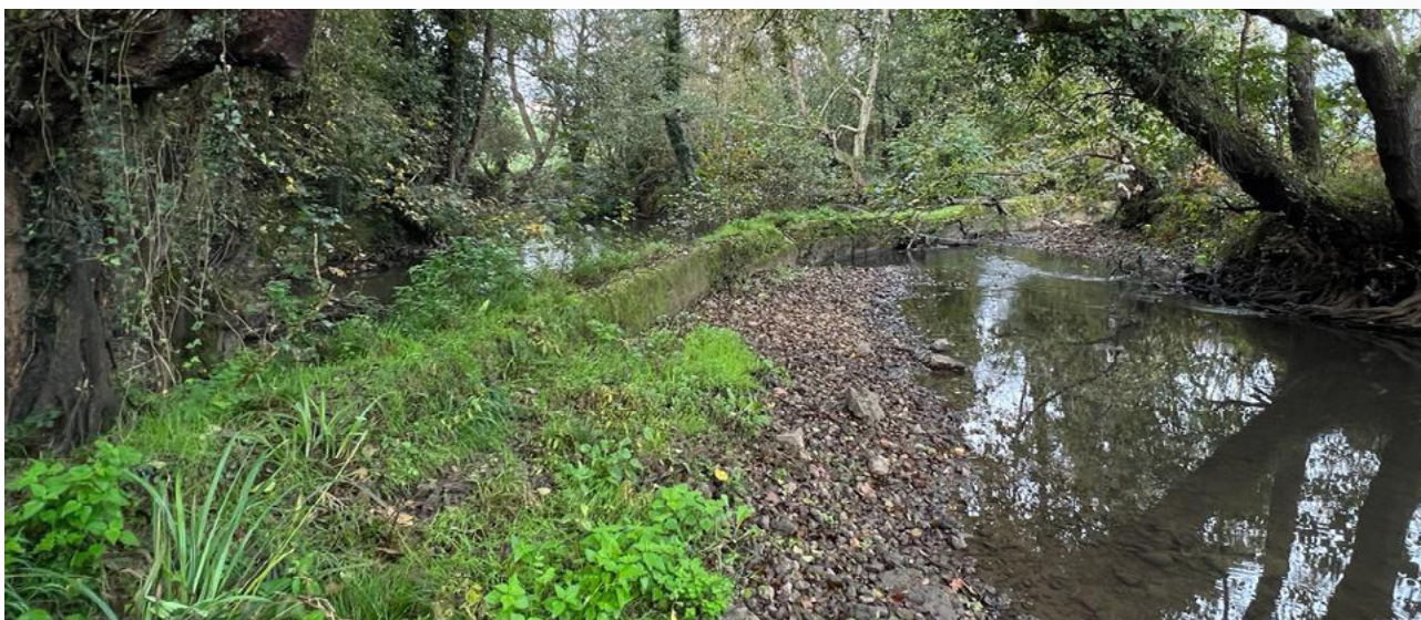
Foto: Demolición azud río Nora en Meres, Siero (Asturias). Antes.
