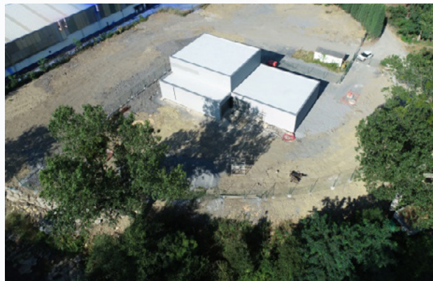
Estación de bombeo de Llodio.
