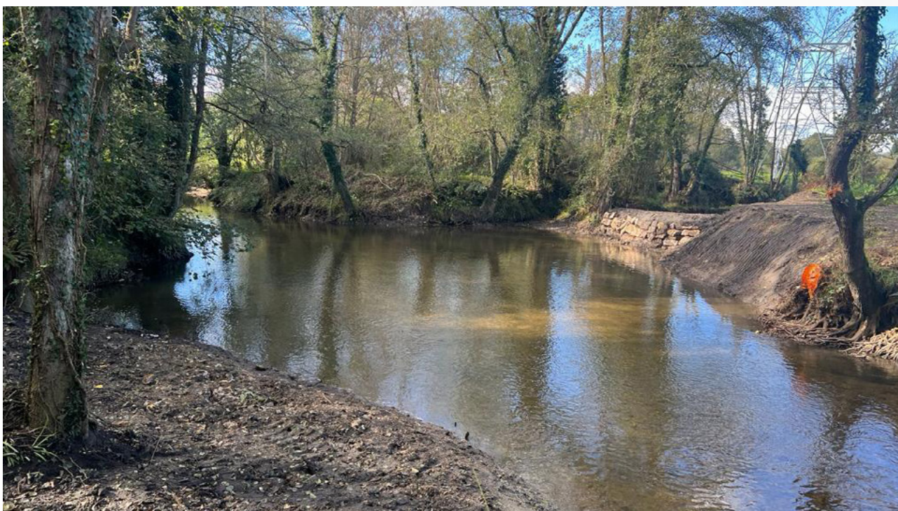
Foto: Demolición azud río Nora en Meres, Siero (Asturias). Después.
