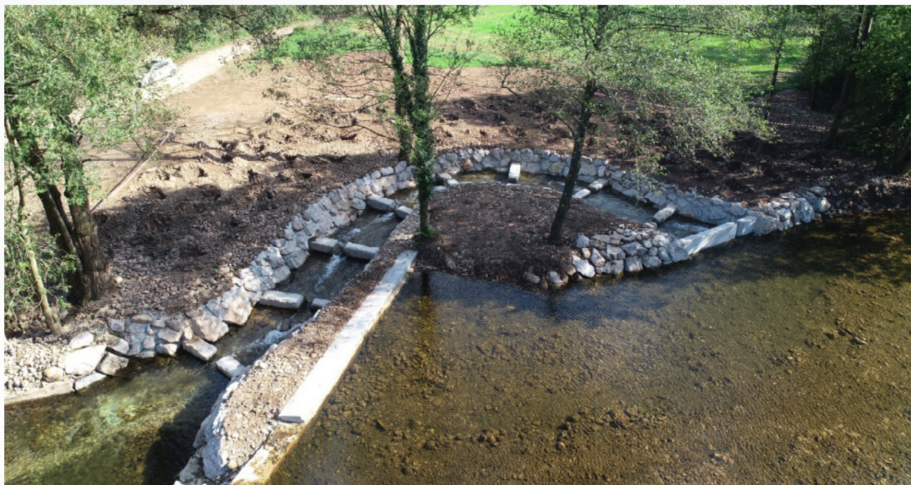
Foto: Demolición azud río Nora en Meres, Siero (Asturias). Después.
