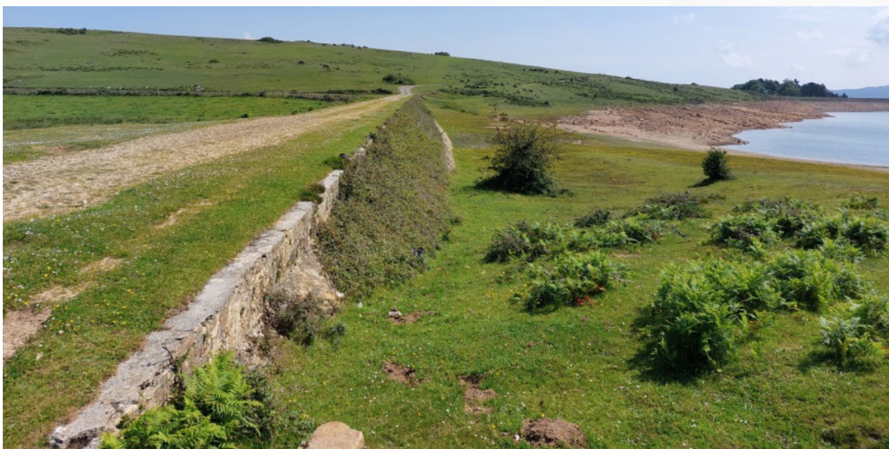
Foto: Presa de Collado en el embalse de El Juncal, Cantabria.
