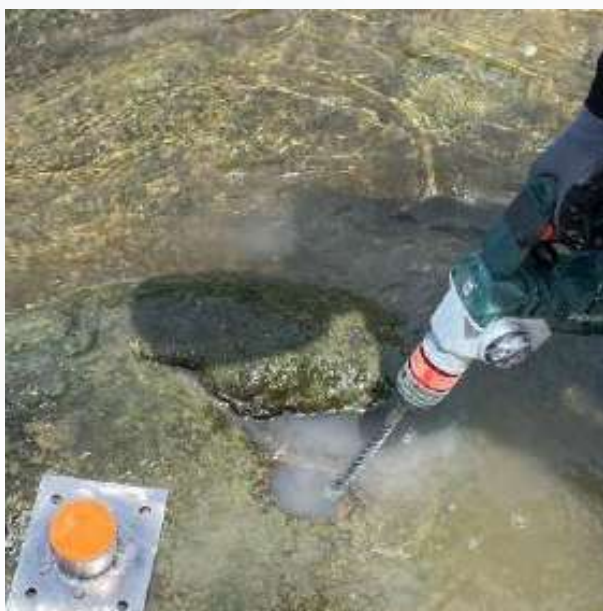
Foto: Inserción de geolocalizador y Plan de implantación. Fuente: INDUROT.
