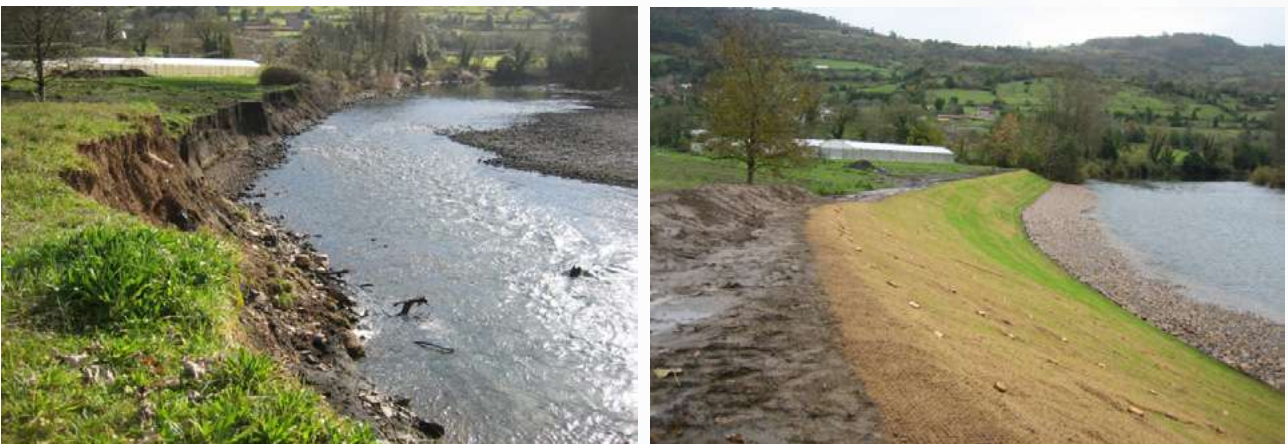
Foto: Actuación en el río Nalón en Murias. T.M. Grado (Asturias). Antes y después.
