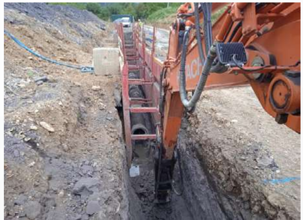
Colocación de la tubería.
