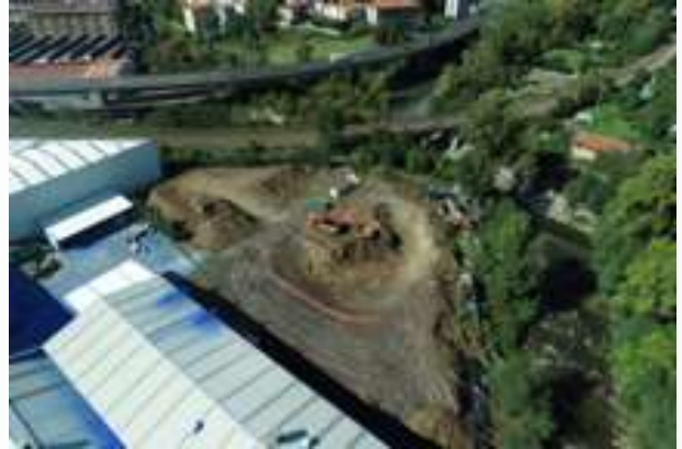
Excavación bombeo Llodio.
