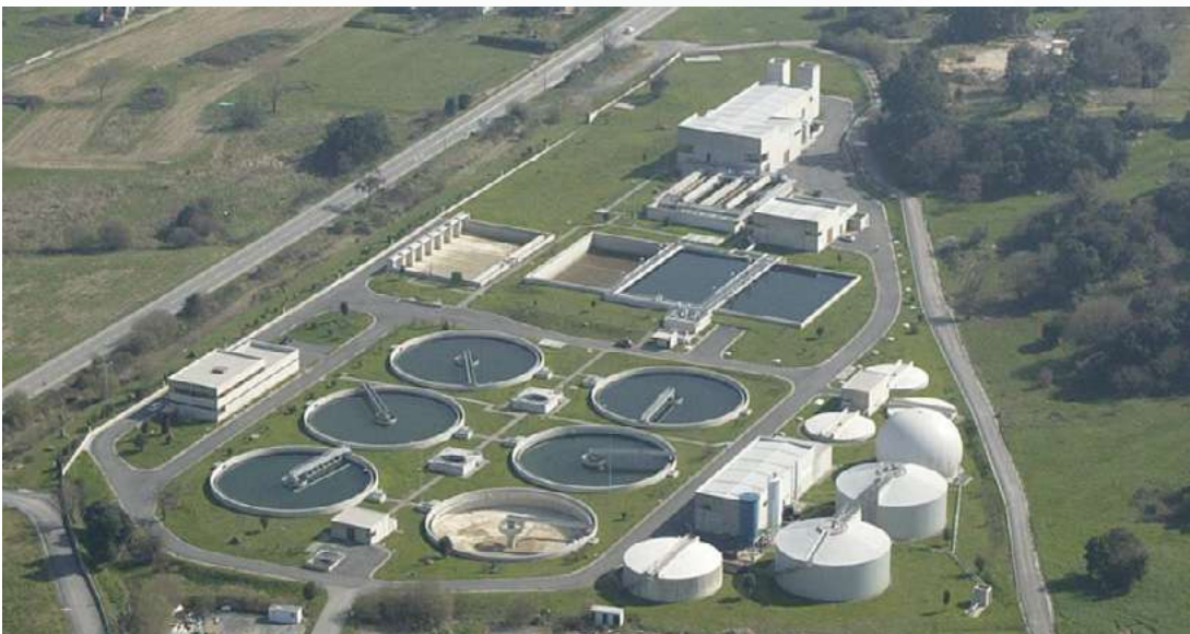
Foto: Vista actual de la EDAR de San Pantaleón.
