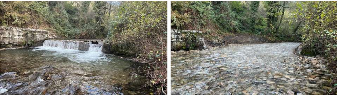
Foto: Eliminación de azud en el río Ibias en Degaña (Asturias). Antes y después.
