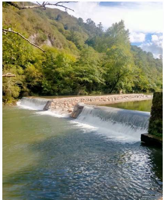
Foto: Permeabilización del azud de Textil Santanderina en el río Saja. T.M. Mazcuerras (Cantabria).
