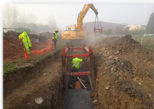
Colocación de la tubería
