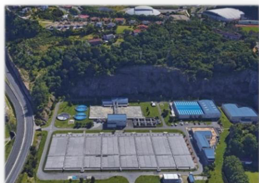
EDAR de Loiola
