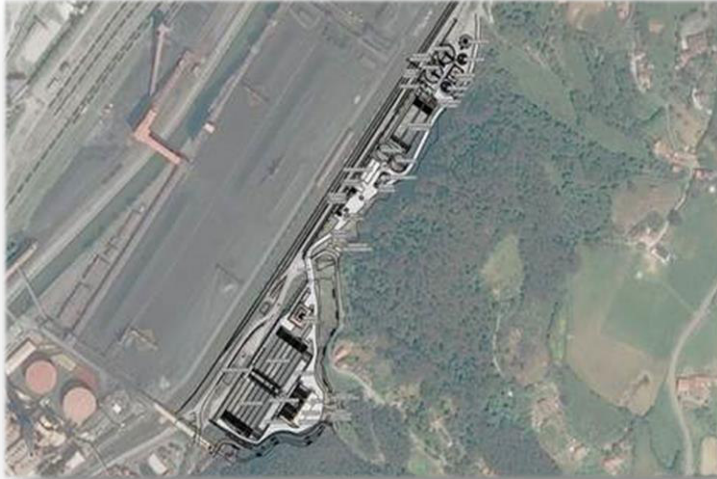
EDAR de Gijón Oeste
