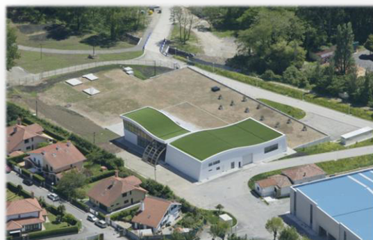
EDAR de Gijón Este
