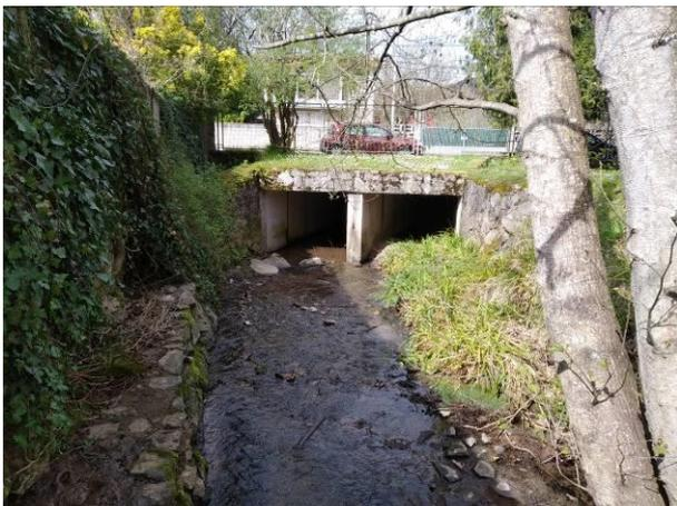
**Figura 6. Cauce existente, muro perimetral y marcos bajo vial**
