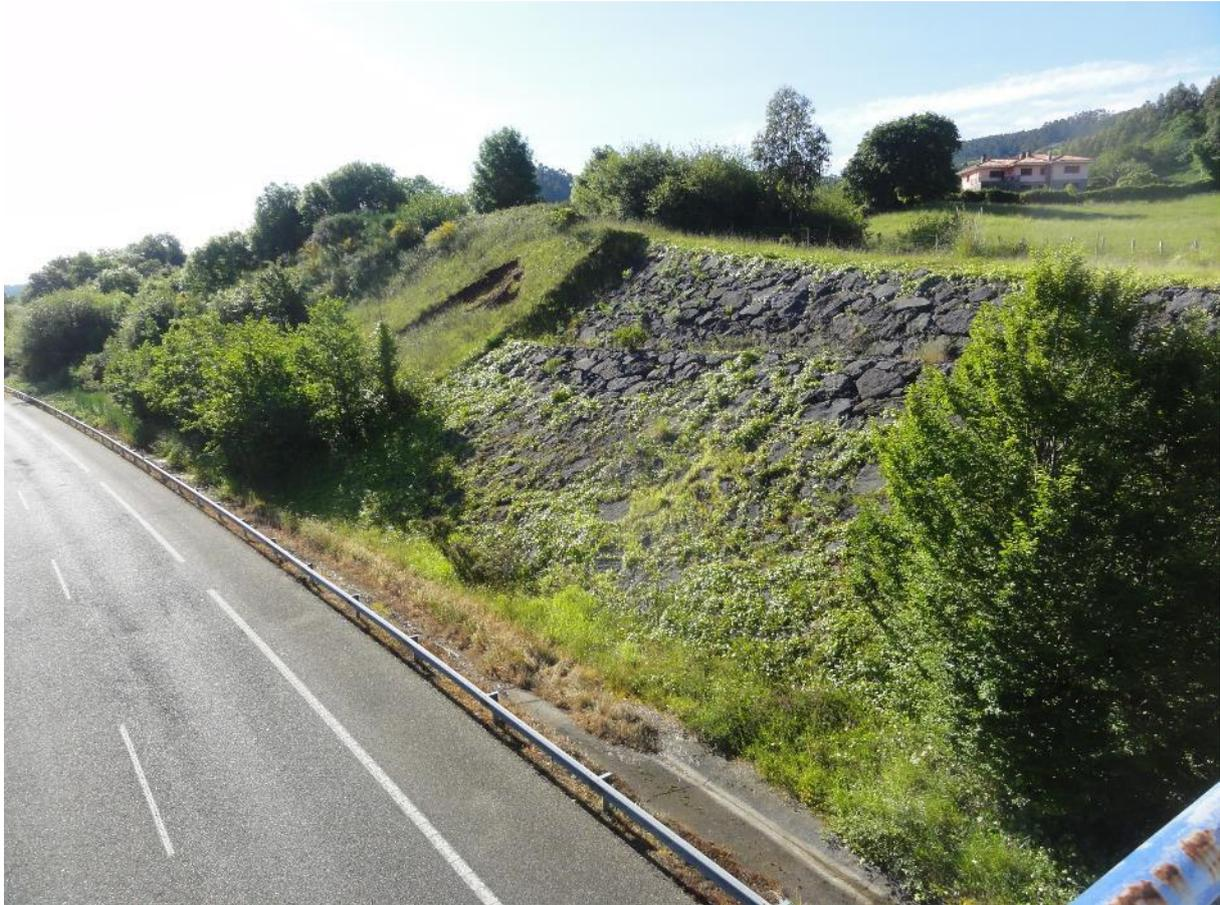
**Foto 6.- Talud en materiales de la unidad T con inclinación y altura aproximadas 3H/2V y H=6-8m, que presenta problemas de estabilidad. Se ha estabilizado con escollera colocada. Al fondo se observa una nueva inestabilidad superficial en la zona no protegida / estabilizada.**
