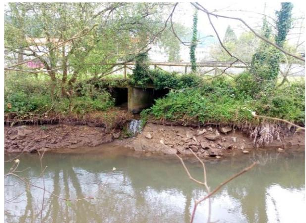
**Figura 7. Marcos prefabricados en su salida a la ría**
