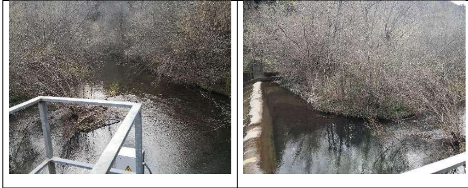
Imagen 2: Imagen del margen izquierdo del embalse por donde se concentra la circulación del caudal del río.
