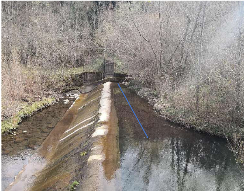
Imagen 3: Imagen de la zona en el que se realiza la retirada manual del material acumulado, para mantener comunicados los dos extremos del azud. La captación de entrada de la escala de peces se localiza al fondo de la imagen
