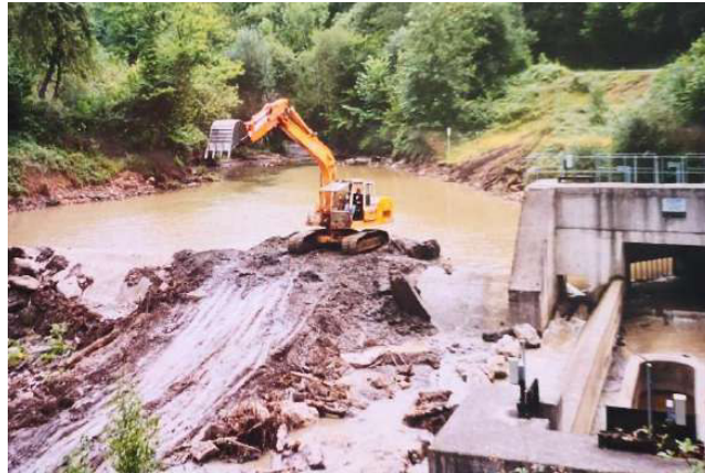
Imagen 6: Rampa de acceso, en los trabajos realizados el año 2004
