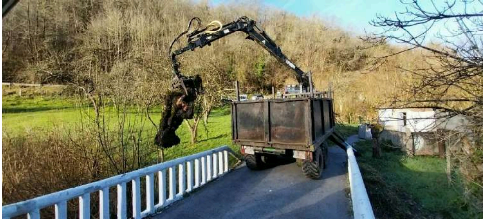
Autocargador retirando restos vegetales del cauce
