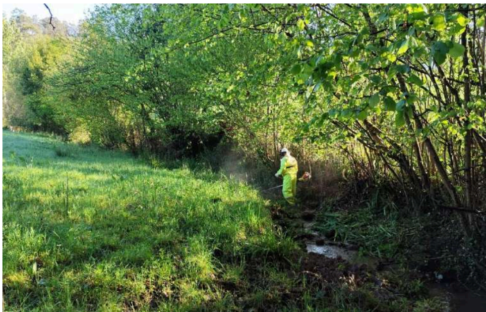
Durante los trabajos: un operario desbrozando vegetación dentro del cauce
