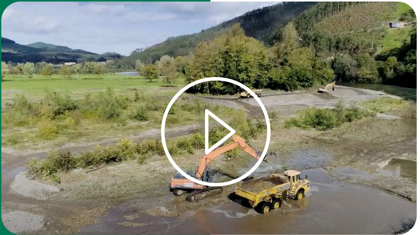
Trabajos de acondicionamiento del cauce del río Nalón en las inmediaciones de Forcinas (Pravia, Asturias)
