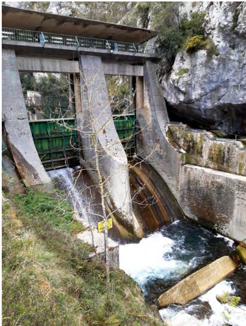
Imagen 1. Vista aguas abajo del azud de Poncebos, donde se ve el cuenco de amortiguación que recoge las aguas que caen desde las compuertas.
