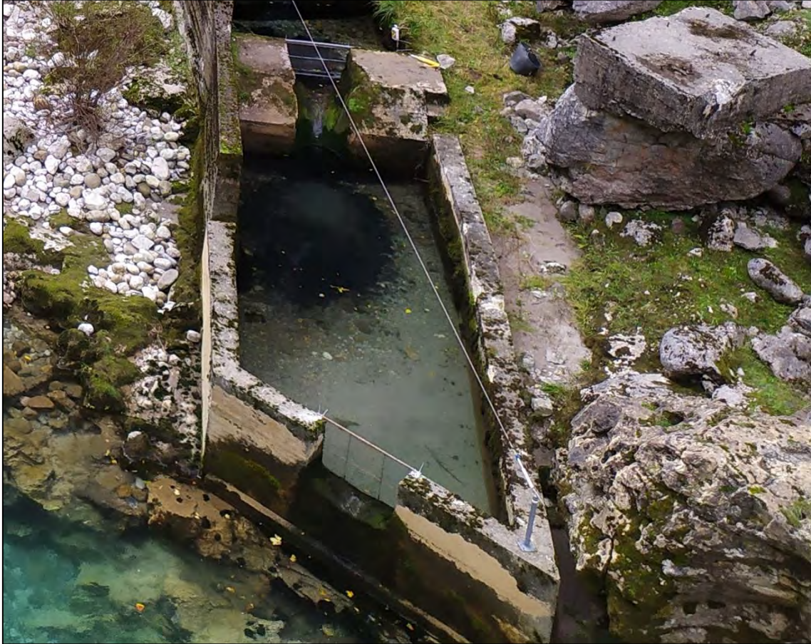
Figura 7. Detalle del último estanque de la escala de artesas del azud de Poncebos.
