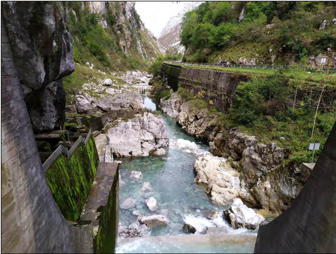
Figura 3. Vista hacia aguas abajo desde el azud de la central hidroeléctrica de Arenas de Cabrales
