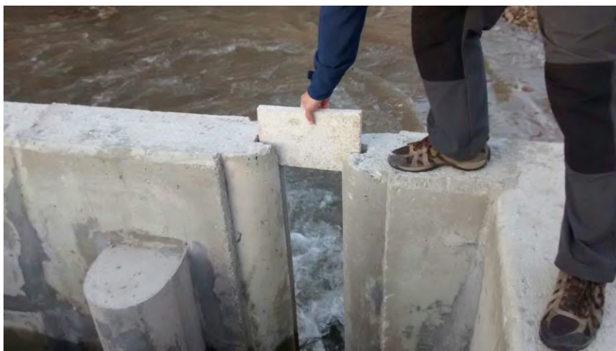
Figura 10. Ranuras para instalación de umbral regulable en el vertedero de más aguas abajo de una escala de artesas (Río Arlanzón, Burgos).
