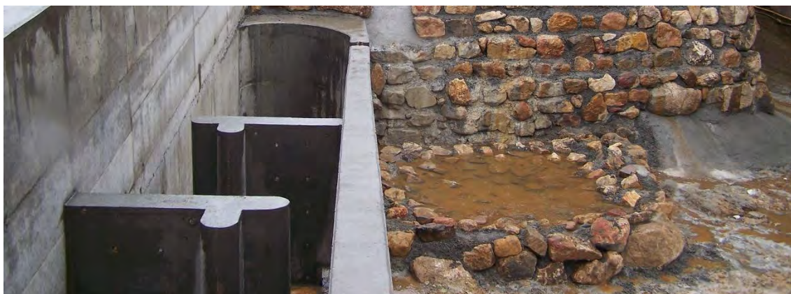
Figura 8. Escala de artesas con poza de disipación de energía en la salida del último vertedero, en el azud de La Flecha en el río Tormes (Salamanca). La imagen la escala se encuentra en seco, pues todavía no se había retirado la ataguía.
