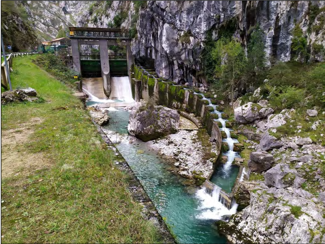
Figura 5. Escala para peces en el azud de Poncebos
