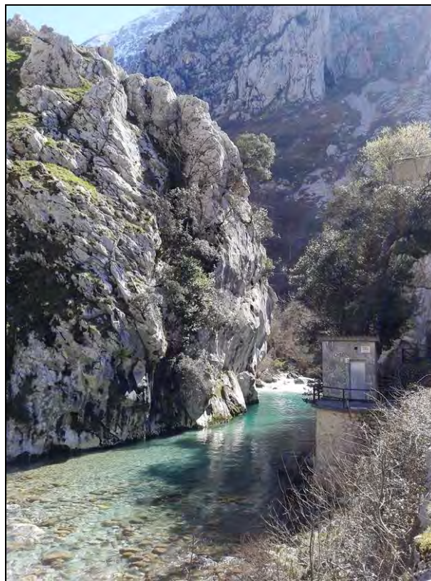
Figura 4. Estación de aforos del río Cares a su paso por Poncebos.
