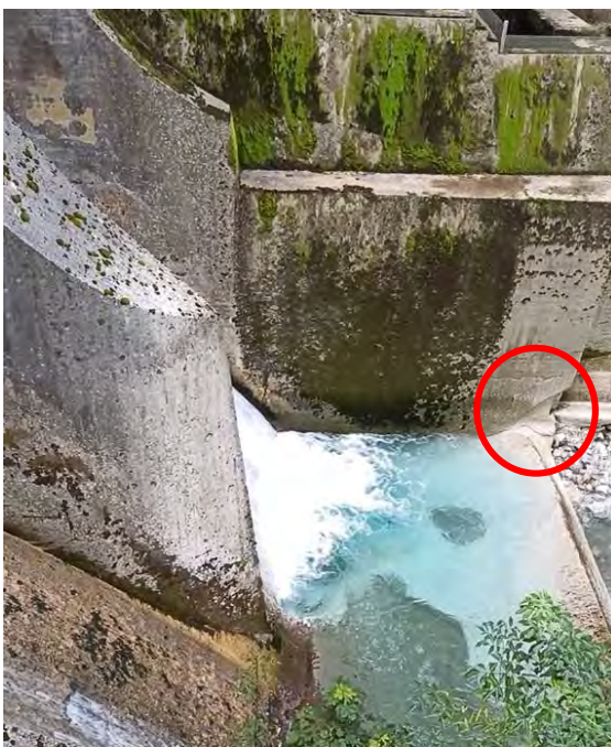
Imagen 3. Zonas erosionadas de los muros de la presa en las dos márgenes del cuenco amortiguador.
