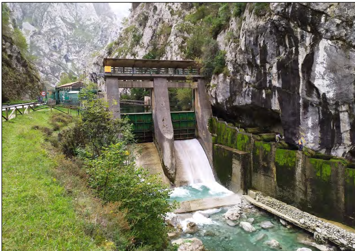
Figura 1. Vista aguas abajo del azud de Poncebos
