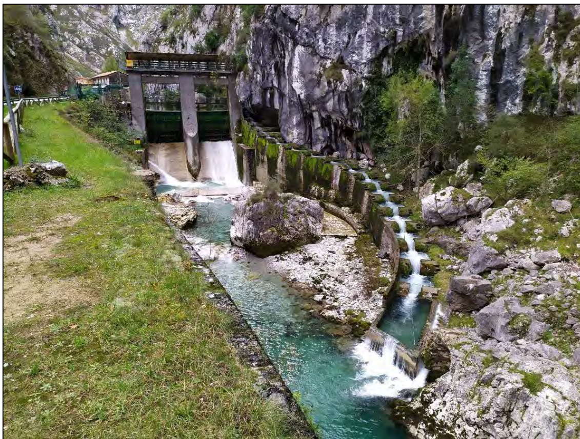
Figura 5. Escala para peces en el azud de Poncebos de la central.
