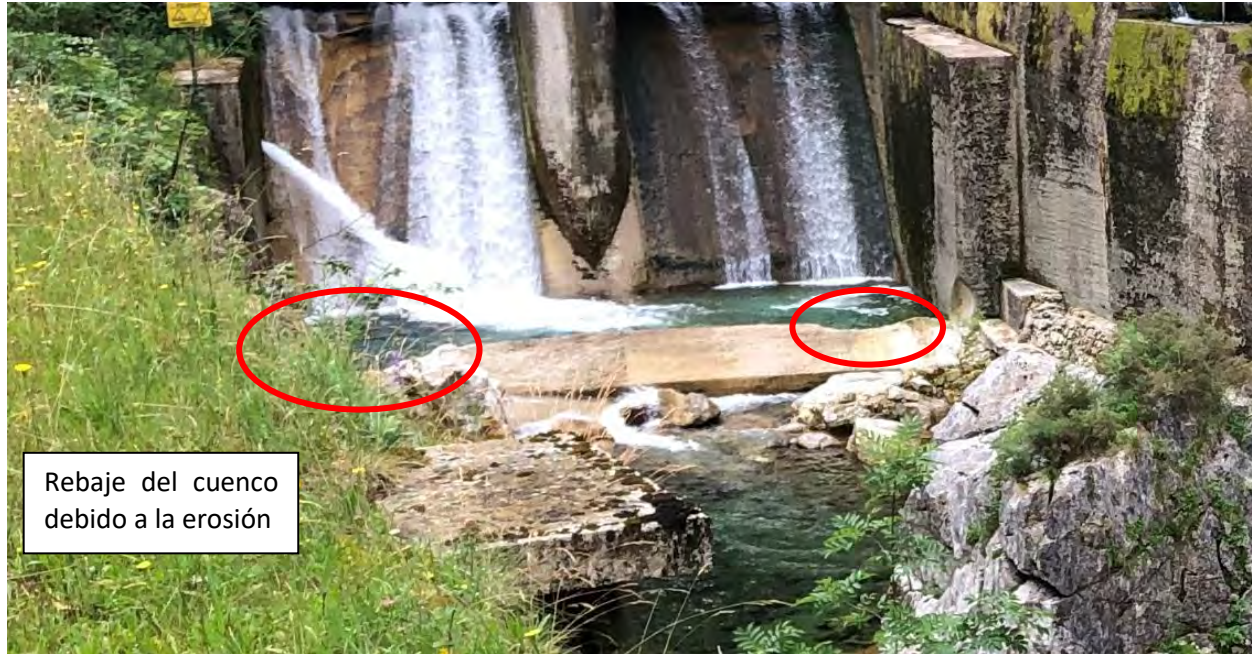
Imagen 2. Estado actual del cuenco amortiguador
